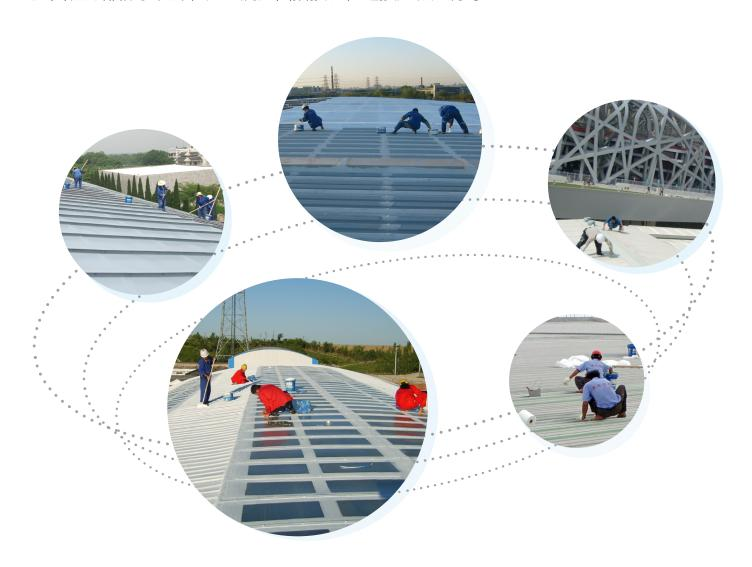
ROOFMATE<sup>®</sup>属于FM4470认可的一级屋面防水系统,可以单独作为一级屋面防水系统,也可以用作各类屋面的维修,亦可用以金属屋面的局部维修。它是内塑性涂料,符合 ASTM D6083的要求,如弹性、机械性能和粘接性。
